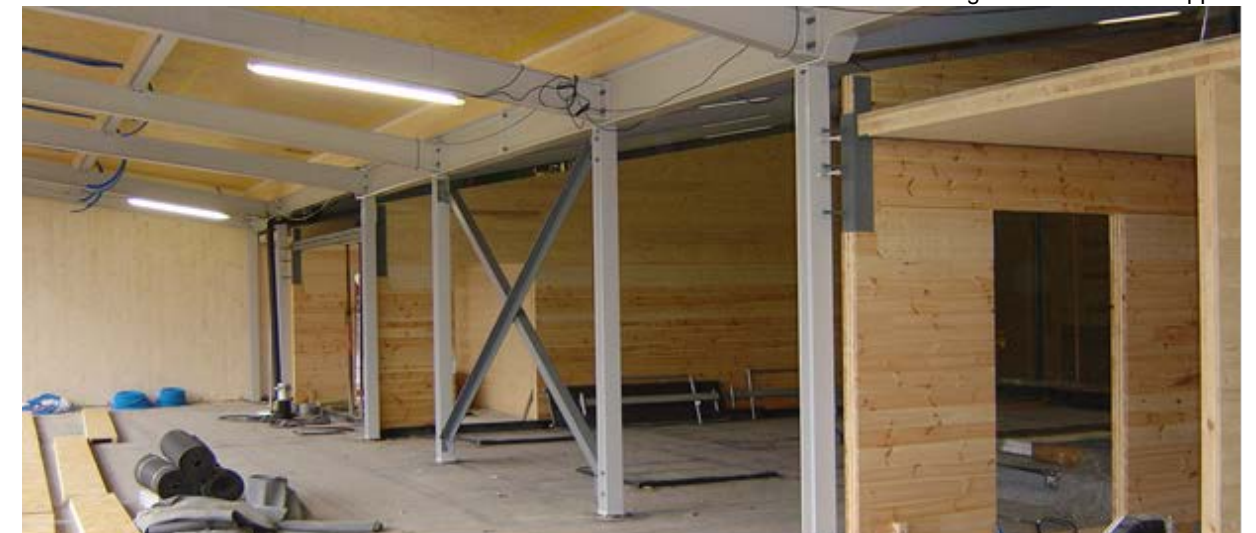
Aufstockung mit Stahl- und Holzbau; Stabilisationskerne in Beton
