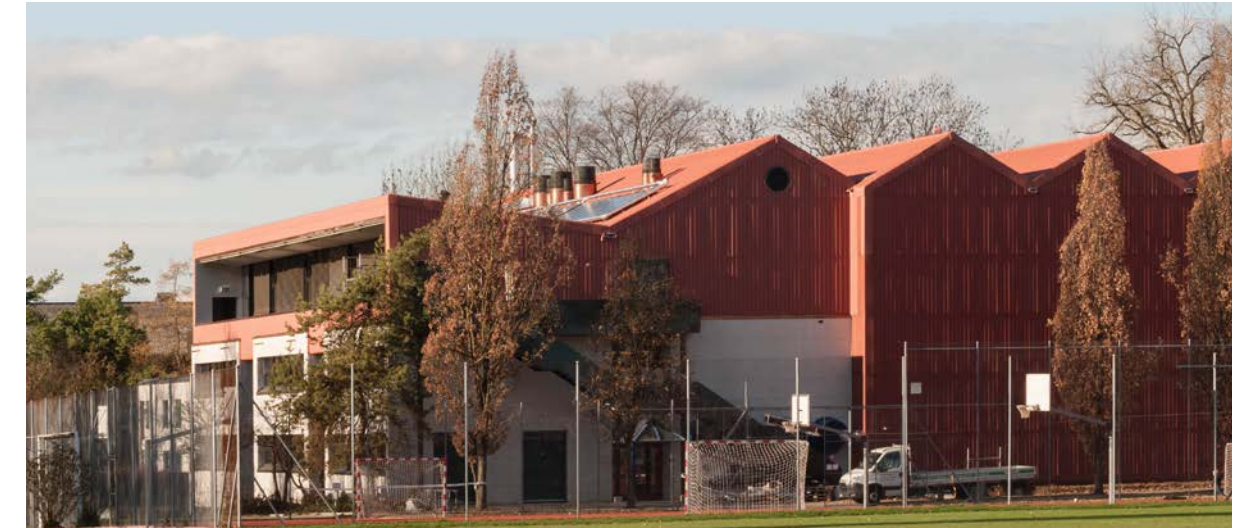
Aussenansicht Aufstockung mit neuer Fluchttreppe
