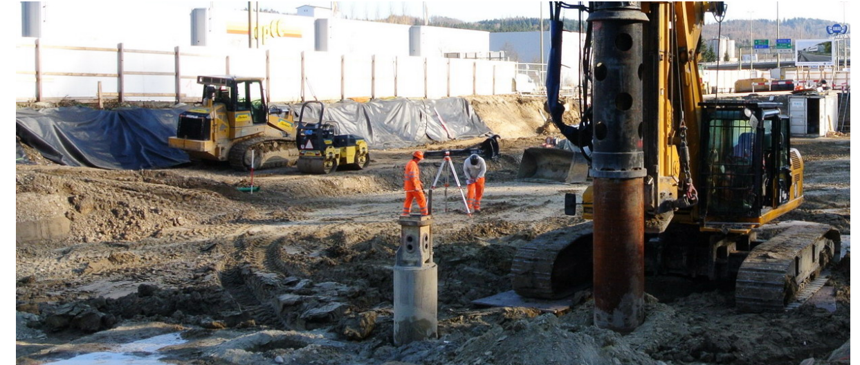
Erstellung von Ortsbetonpfählen
