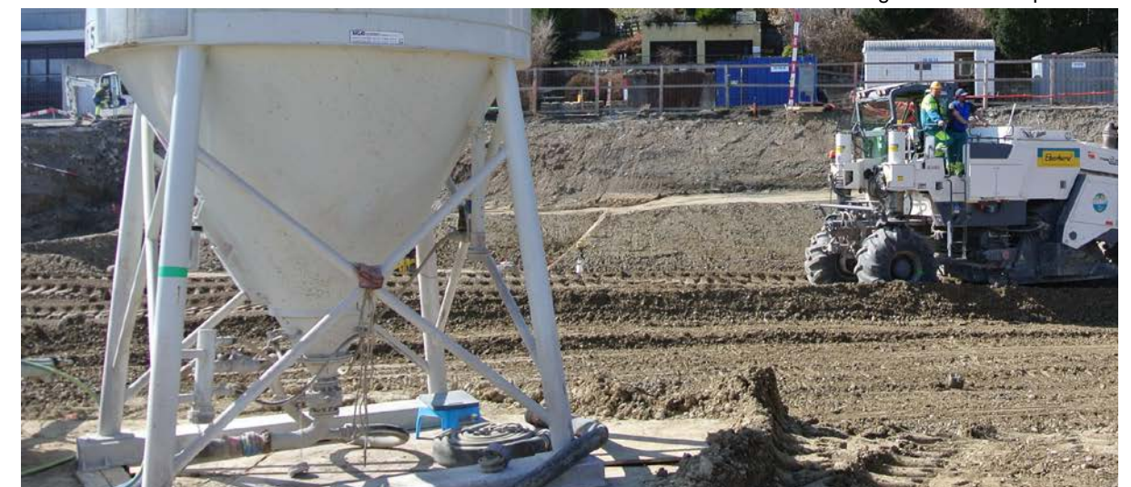
Verbesserung Baugrund mit Kalkstabilisation
