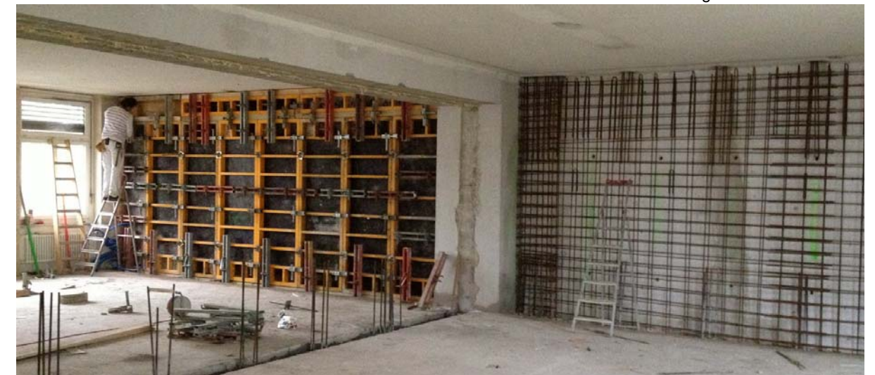
Einzug von Erdbebenwänden
