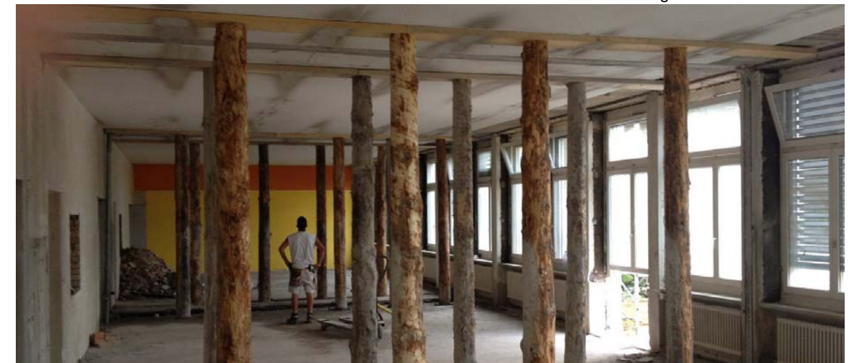
Spriessung vor Einzug neues Tragsystem
