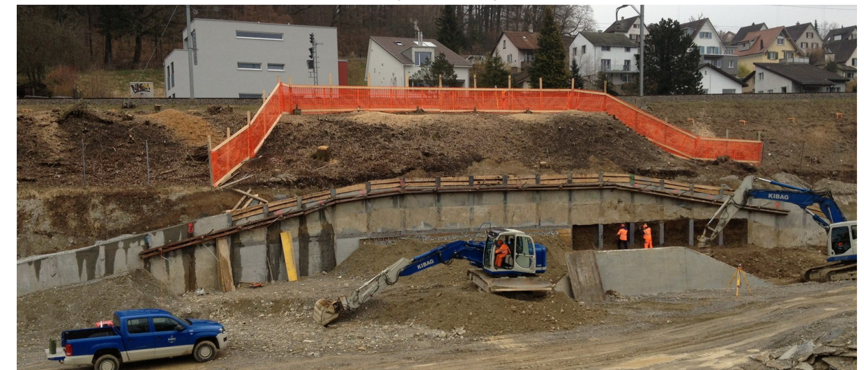
Aushub mit Rückbau und künstlicher Auffüllung
