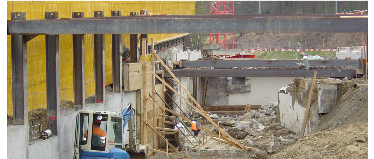
Gespriesste Baugrube zu bestehendem Gebäude während Rückbau
