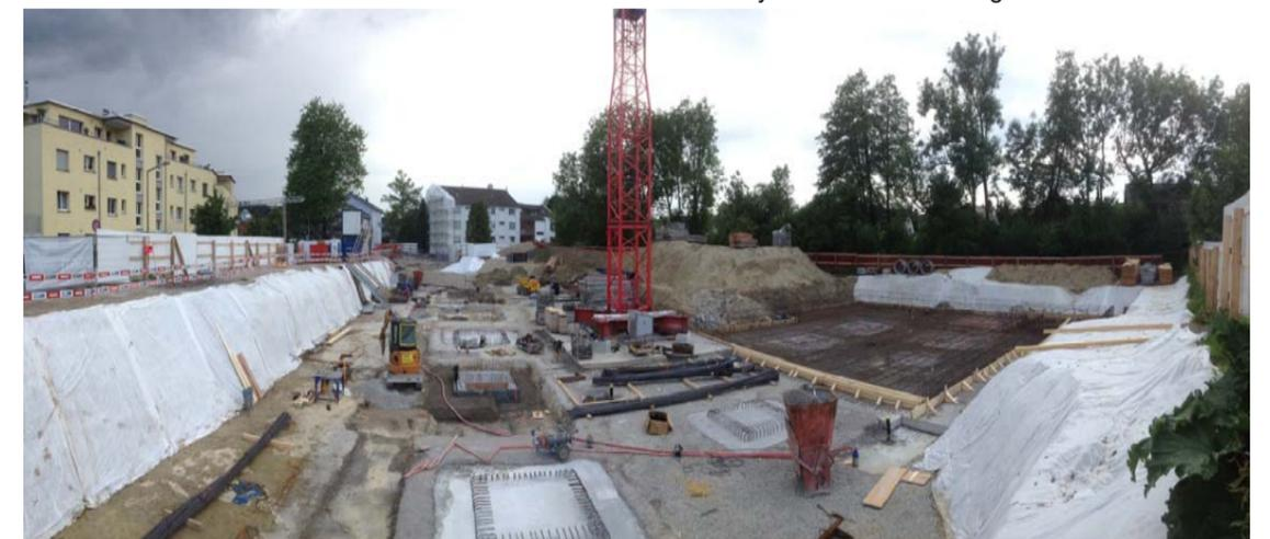
Aushub mit geböschter Baugrube
