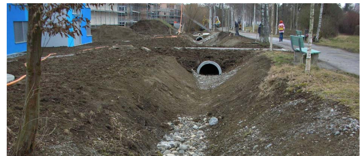
Kiessohle bei Feuchtstandorten
