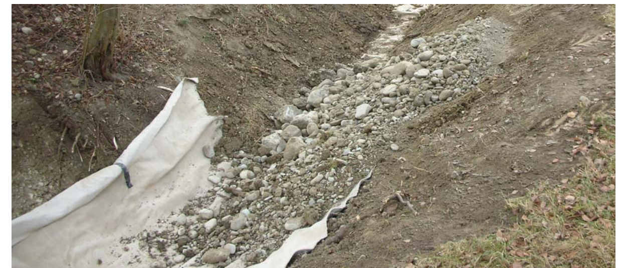
Abdichtung mit Bentonitmatte im Bereich der Feuchtstandorte
