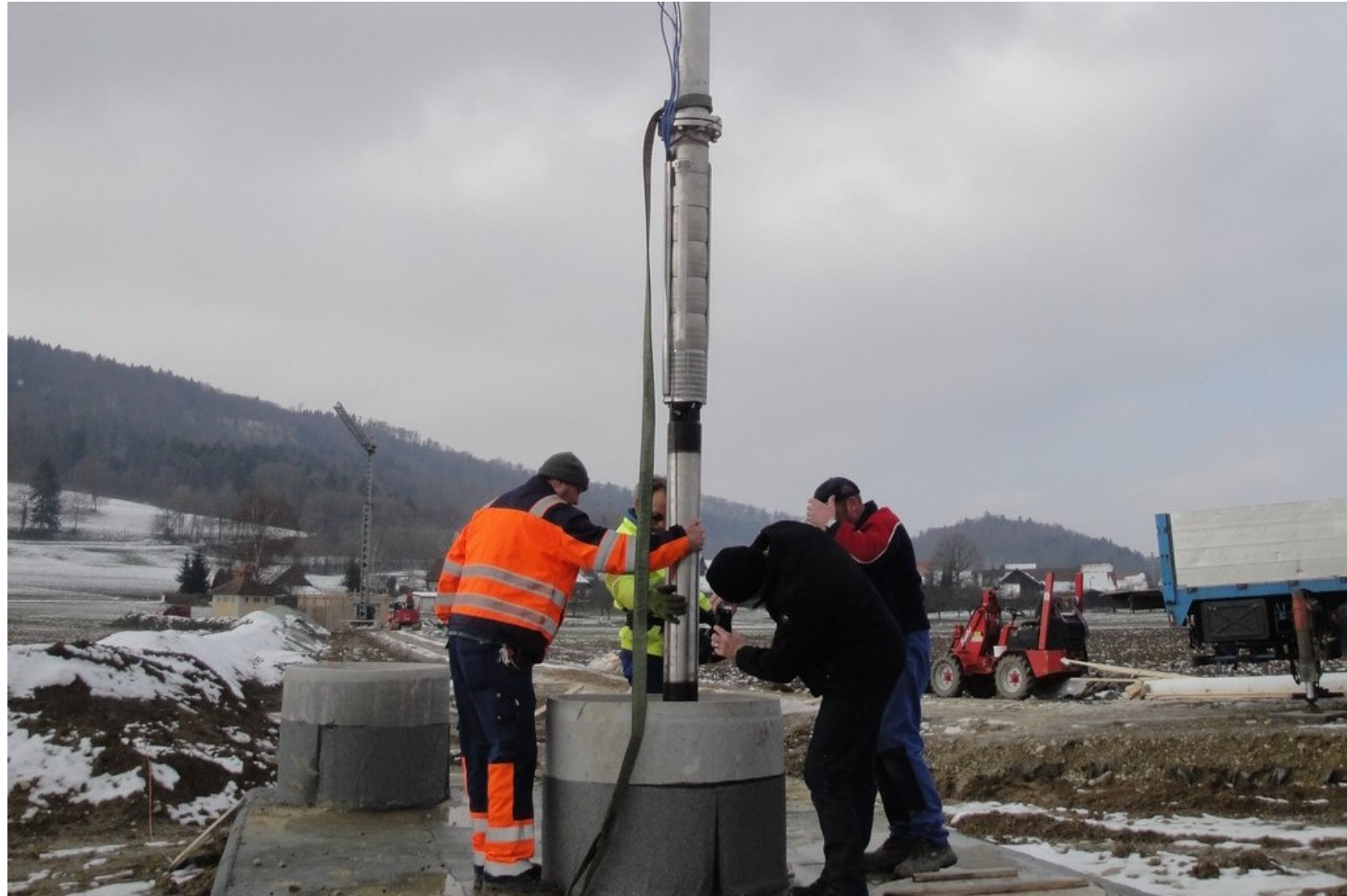
Versetzen einer Unterwasserpumpe
