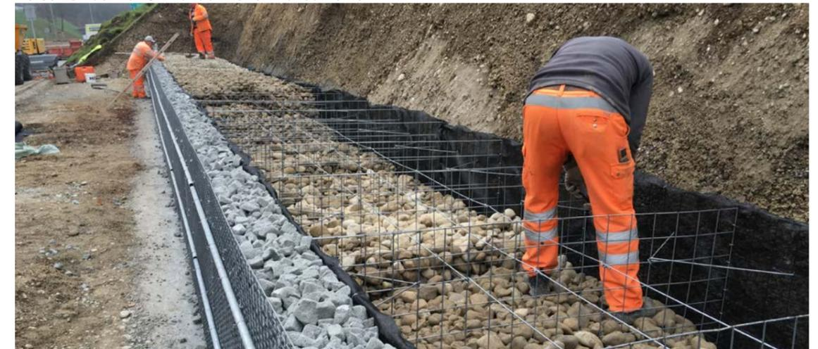
Erstellen einer Steinkorbstützwand mit Schallschutzschicht
