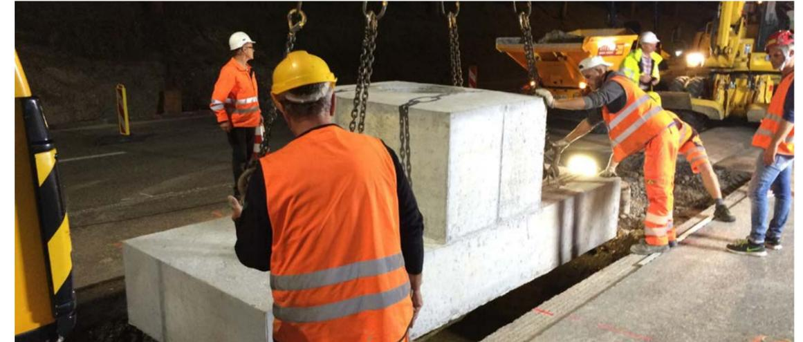
Versetzen der vor Ort vorgefertigten Fundamente
