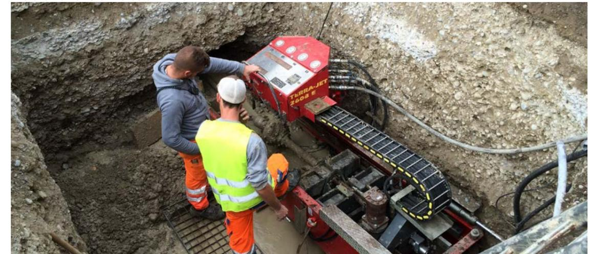
Grabenloser Bau der Kabelschutzrohre
