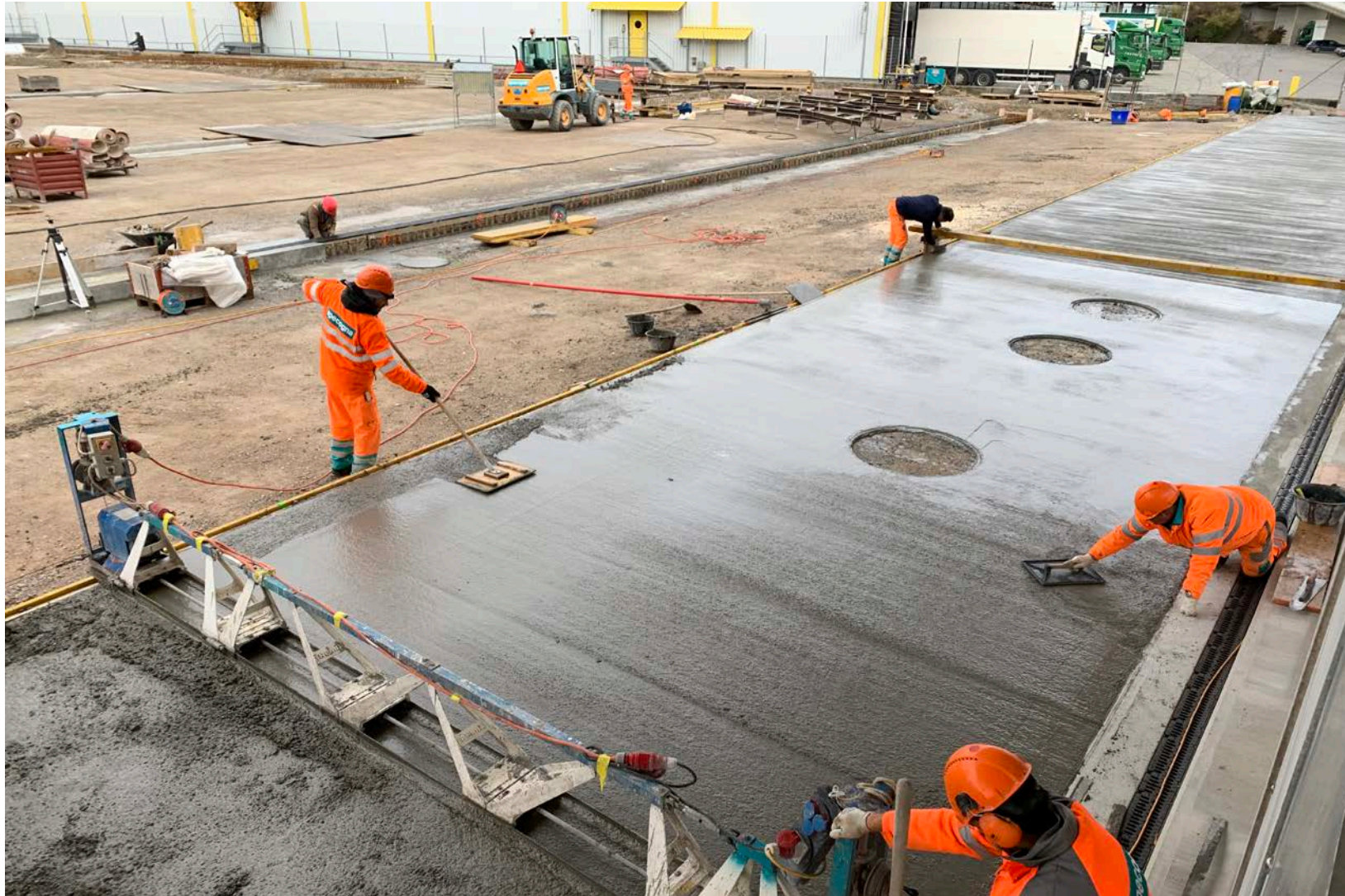
Balkenfertiger und viel Handarbeit
