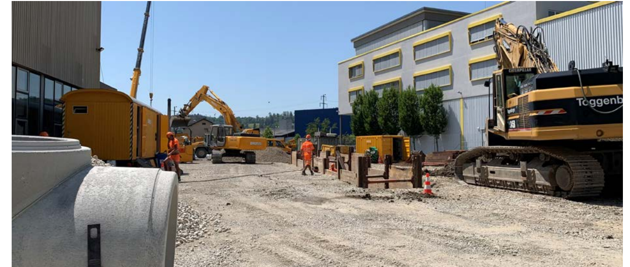
Bau der unterirdischen Retention für Meteorwasser
