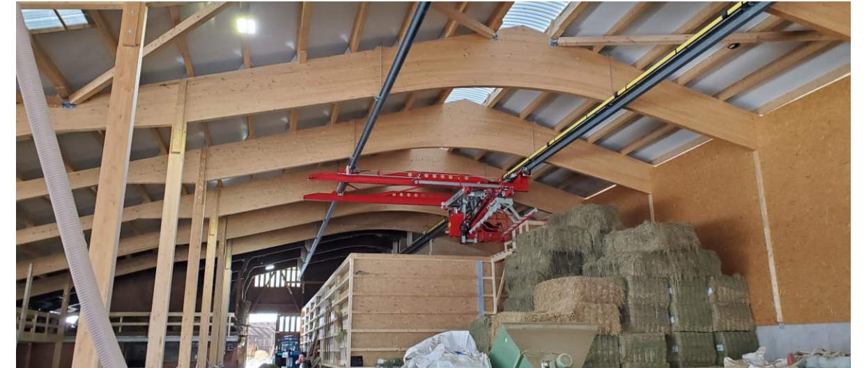
Holzkonstruktion mit Heukran (Verbindung mit altem Stall)
