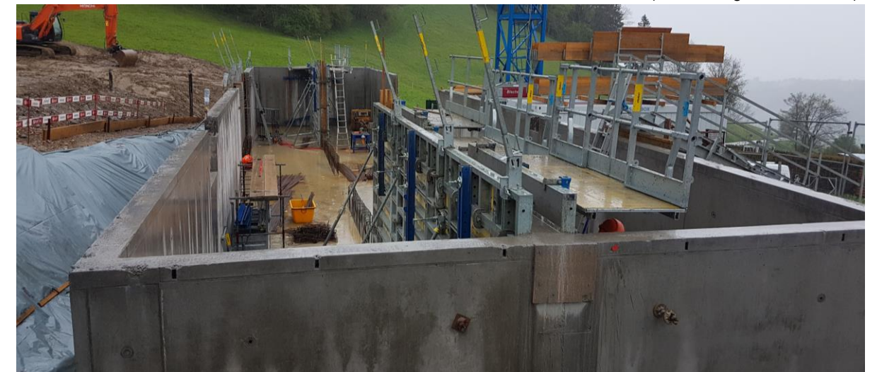
Jauchegrube mit einem Fassungsvermögen von ca. 650m 3
