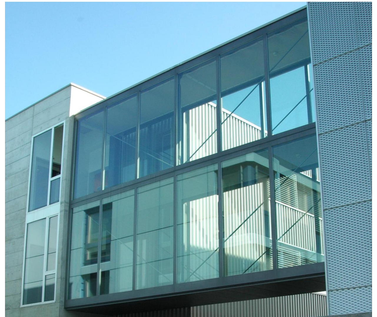
Filigrane Stahlteile werden entsprechend dem Kraftfluss gezielt eingesetzt
