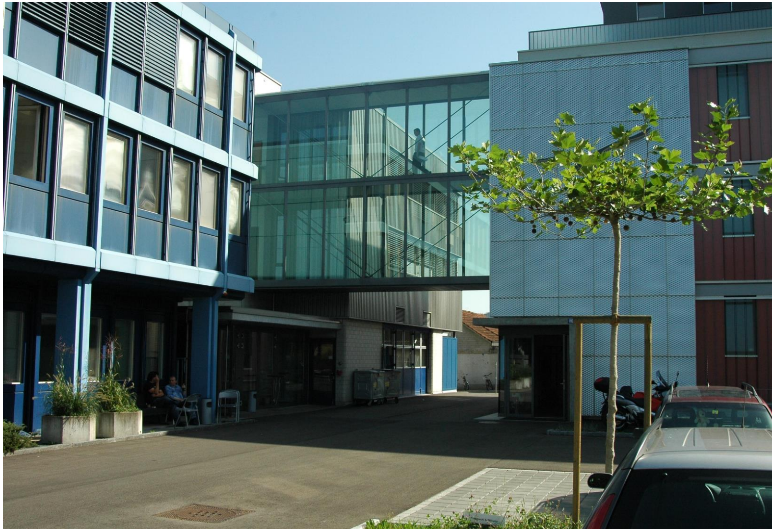
Schlanke, zweistöckige Stahlpasserelle als Verbindung zwischen Neubau und dem bestehenden Gebäude
