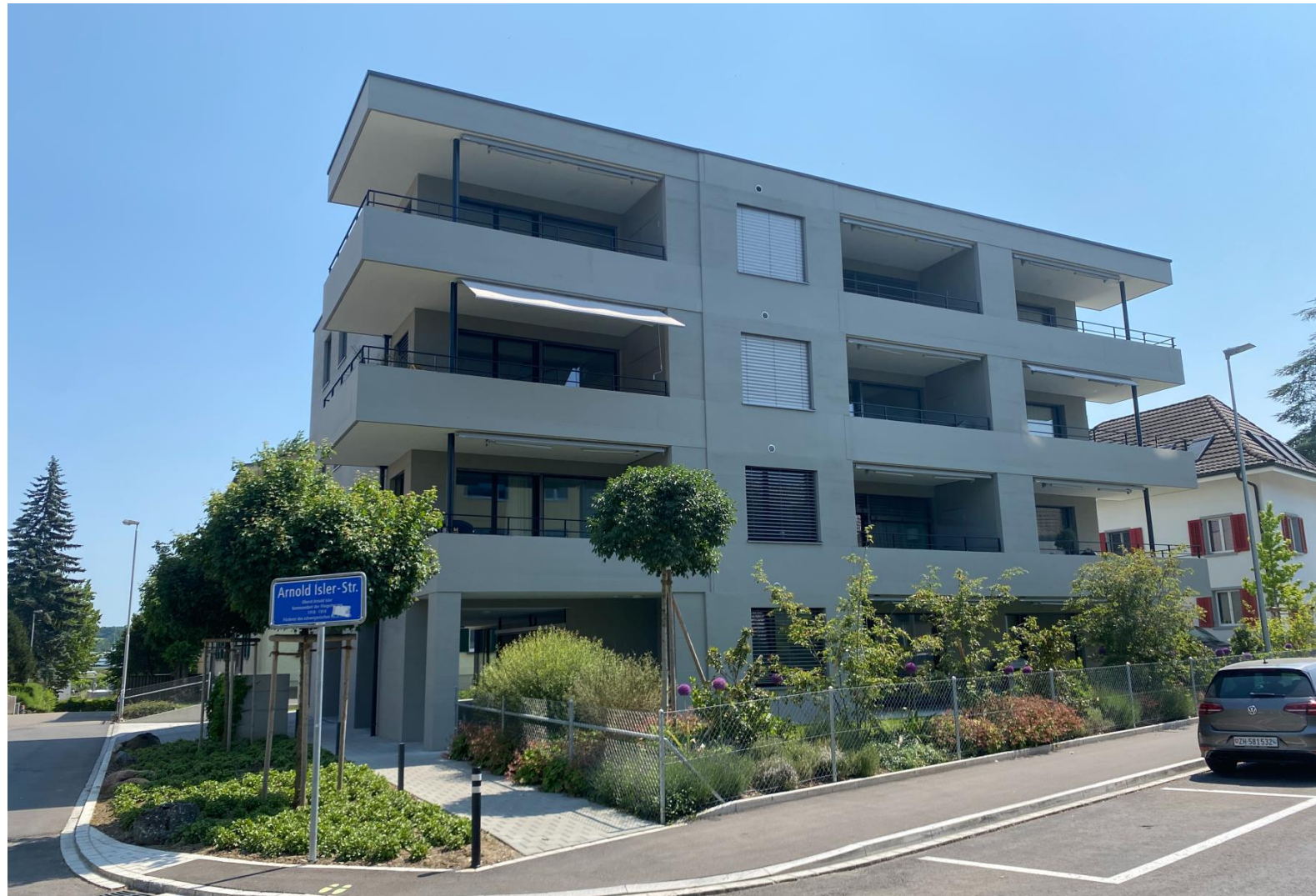
Mehrfamilienhaus mit grosszügigen, weit gespannten Balkonen
