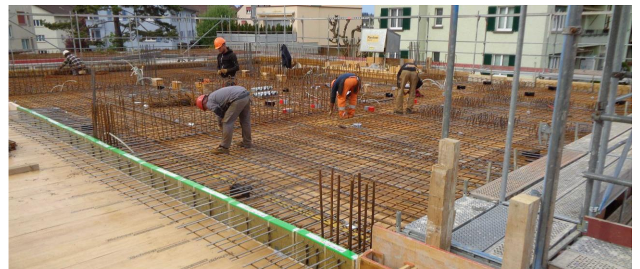
Flachdecke mit auskragenden Balkonen
