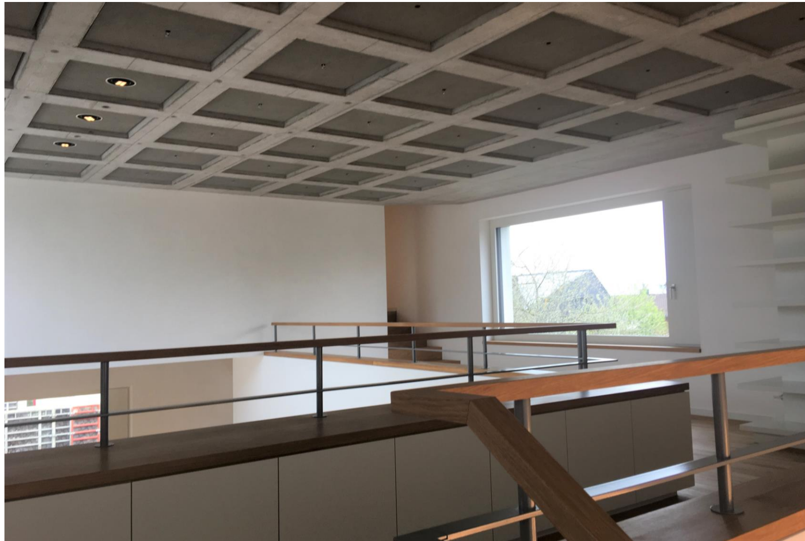
Kassettendecke mit schlanken Stegen und integrierter Beleuchtung.
