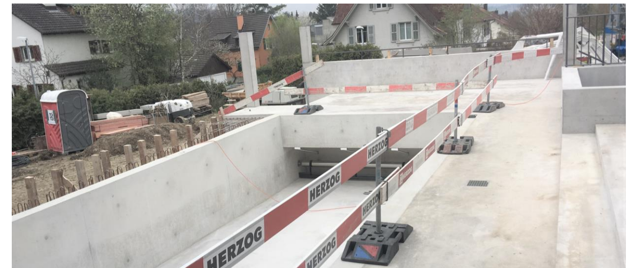
Ausgedehnte Poollandschaft in Sichtbeton
