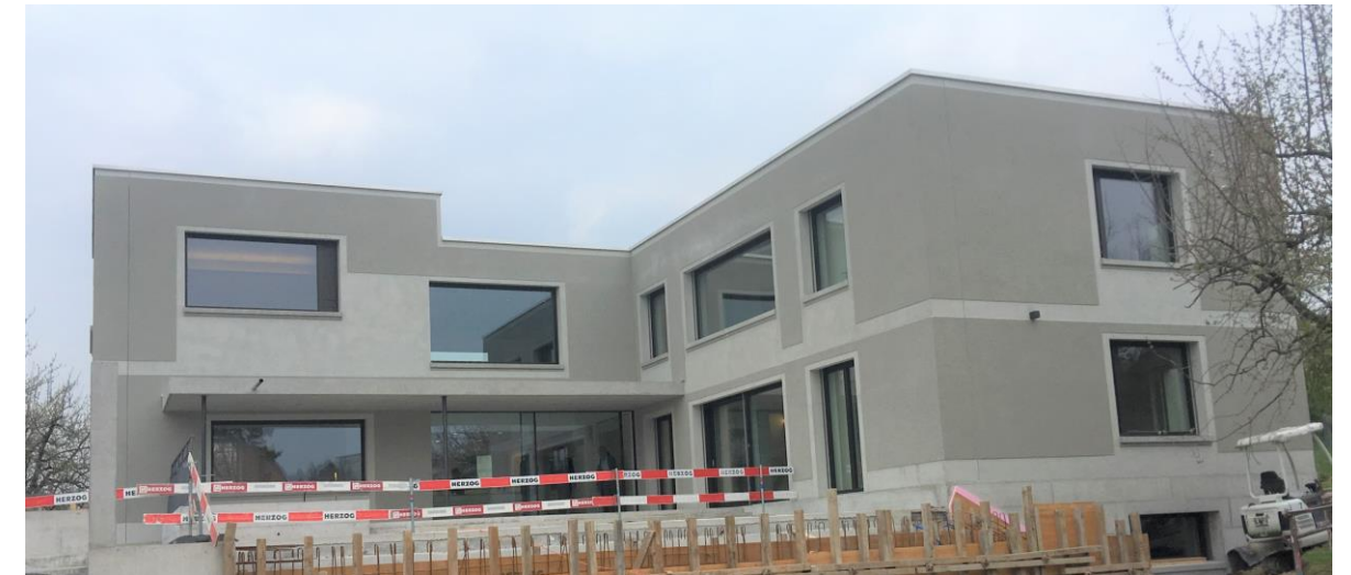
Zweischalenmauerwerk mit verputzter Aussenschale
