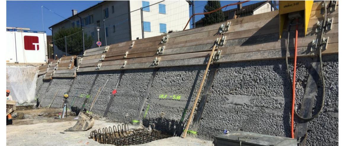
geböschte Baugrube mit Baumeisterrühlwänden zur Böschungssicherung
