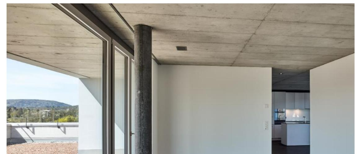
Sichtbetondecken mit weit auskragenden Balkonen
