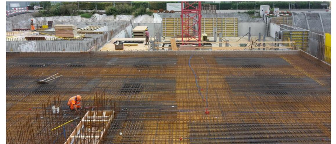
weit gespannte Tiefgaragendecke mit Durchstanzsicherungen
