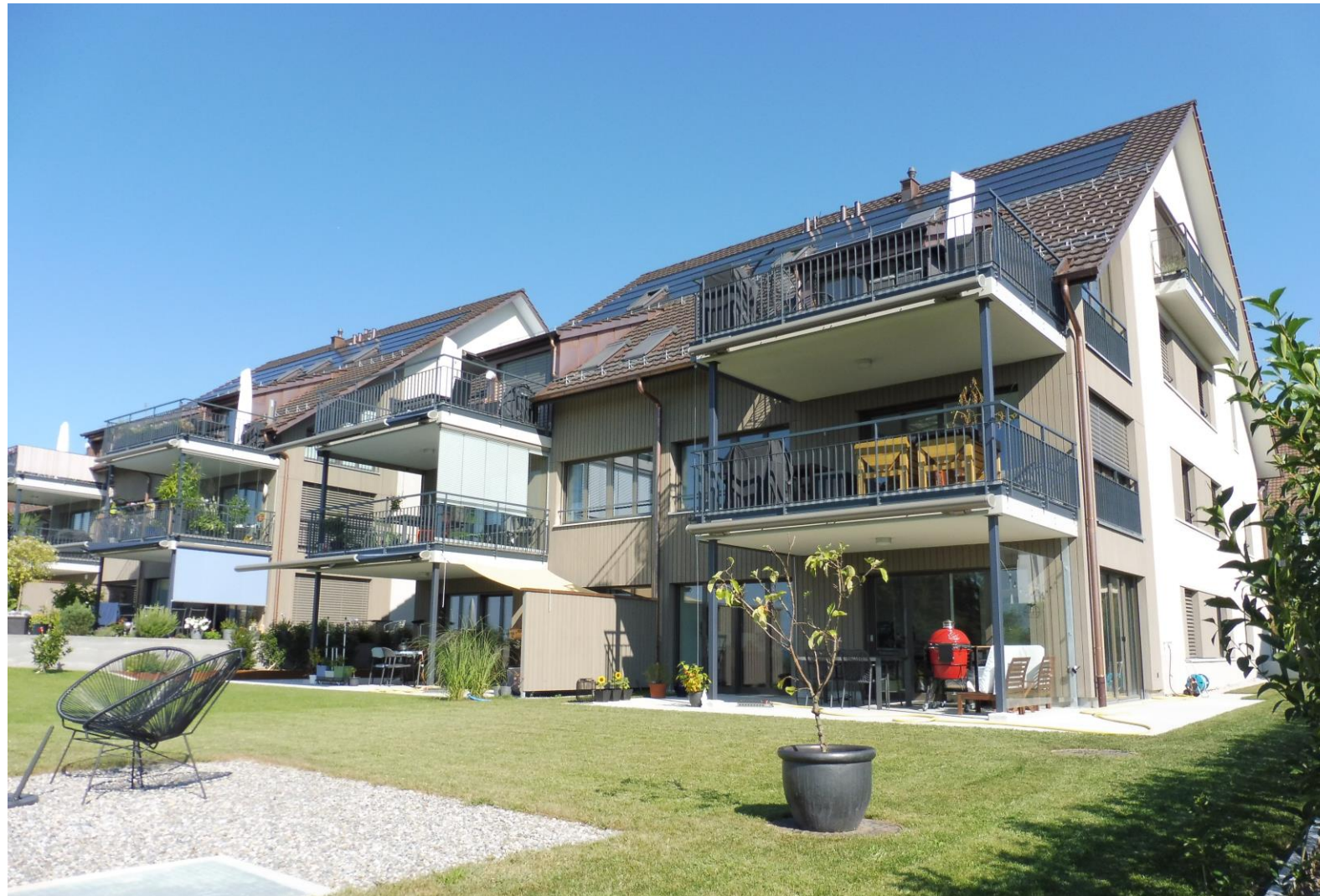
Mehrfamilienhäuser in Massivbauweise mit Einsteinauerwerk, Dachstuhl in Holz
