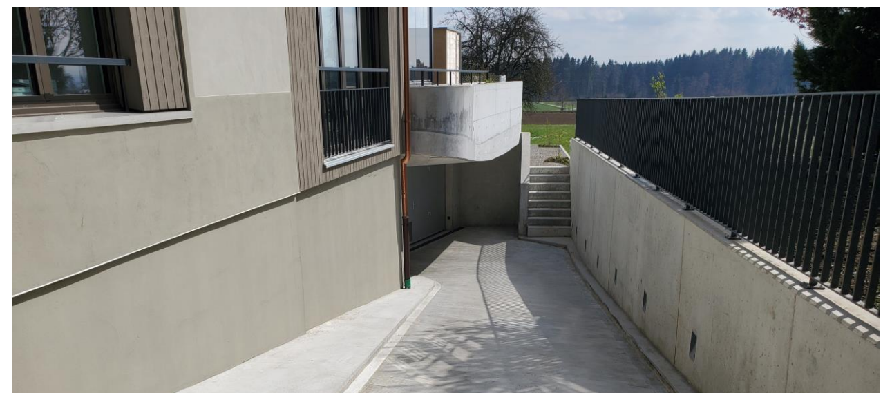
Rampenabfahrt mit Gebäudeabfangung
