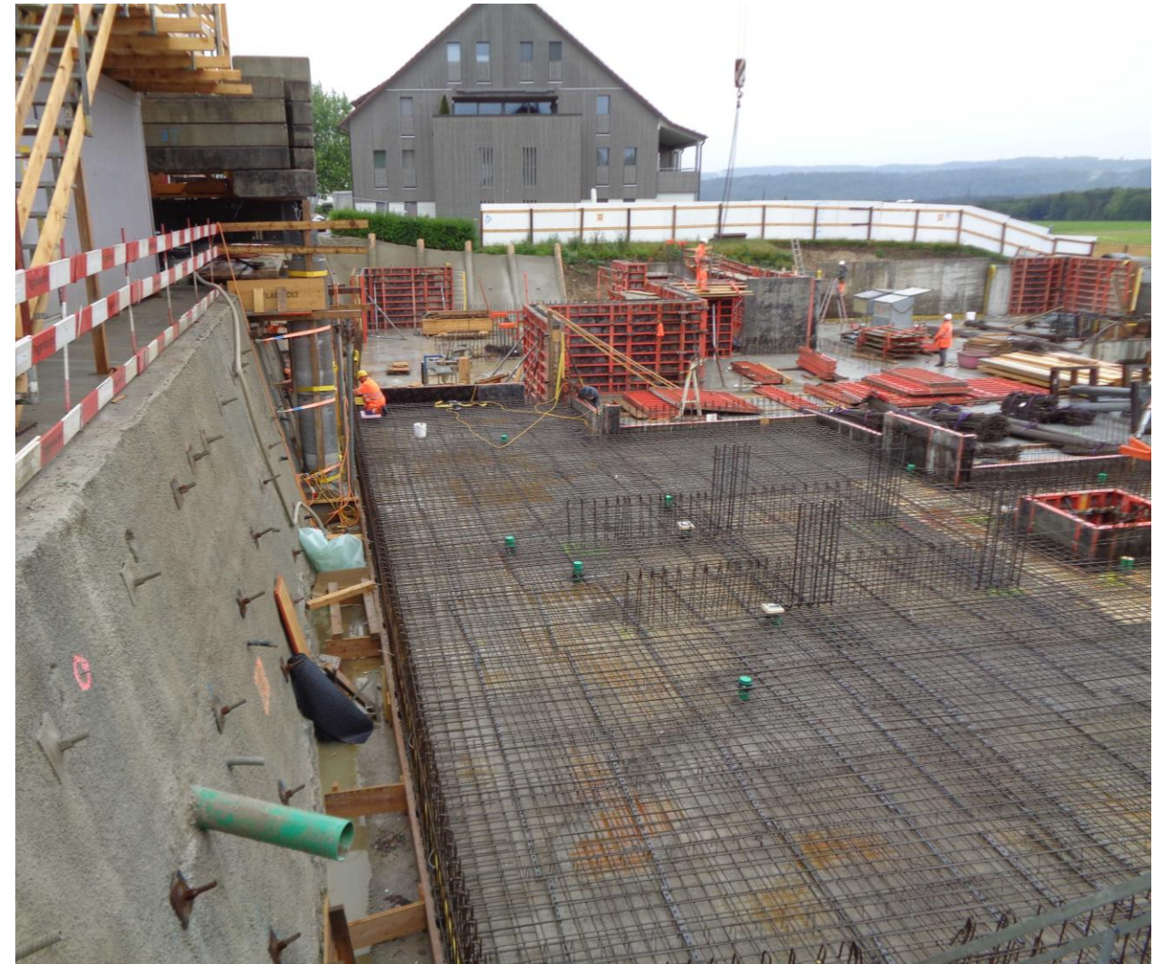
Kellergeschoss mit bereichsweise Gelber Wanne
