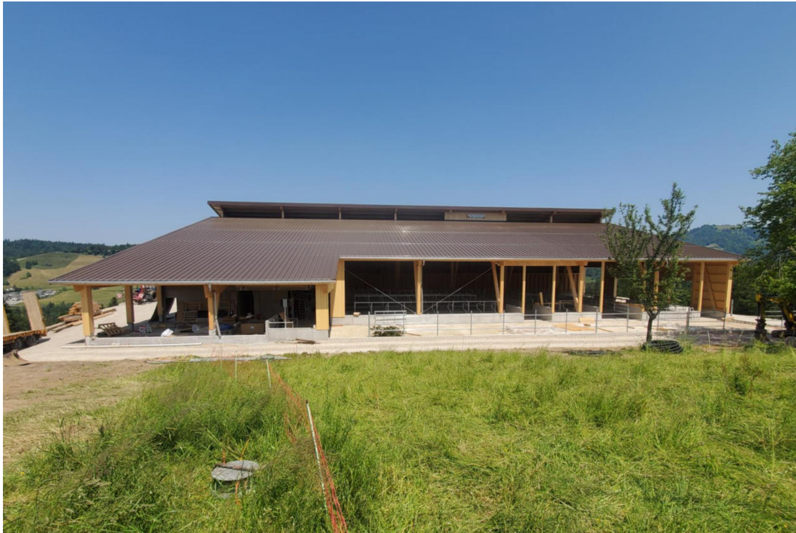
Neubau Landwirtschaftsgebäude mit Jauchegrube und Remise
